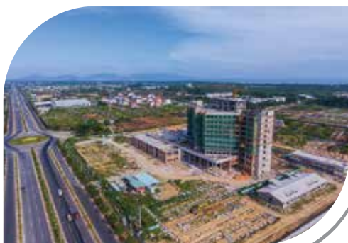
BỆNH VIỆN ĐA KHOA VŨNG TÀU VUNG TAU GENERAL HOSPITAL
